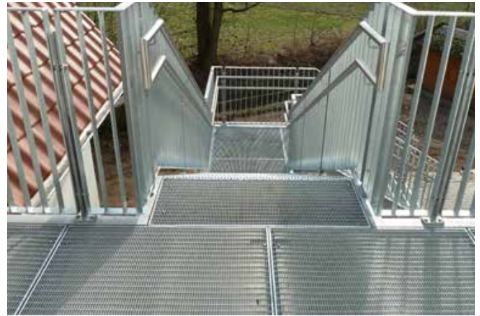
Treppenlauf aus Gitterrosten
