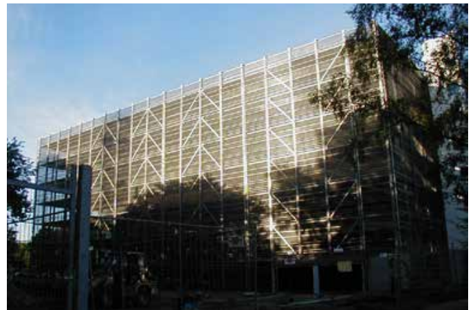
Parkhausfassade Beiersdorf, Hamburg
